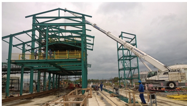
Slika 1 – Podizvođač na gradilištu STSI-a, kod radova na sastavljanju teških dijelova i sklopova
