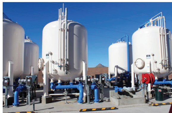
Slika 2 – Pogon za napredne oksidacijske procese tvrtke Ozone Solutions primjenjuje tri dokazane tehnologije obrade (ozon, UV, H 2 O 2 ). Napredni oksidacijski procesi (eng. advanced oxidation process, AOP )
