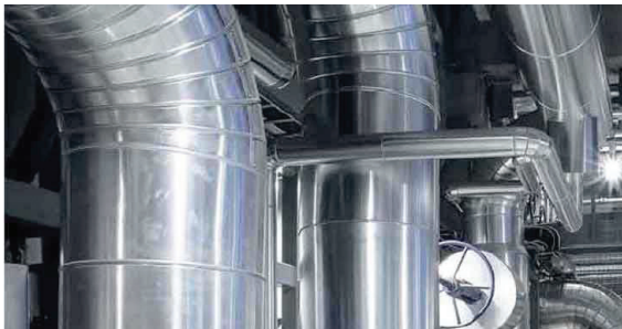
Slika 7 – Izolirani cjevovod s metalnim plaštom. Kako nema udubljenja, ta izolacija najvjerojatnije ima ista svojstva kakva je imala i na početku životnog vijeka. (izvor http://www.wermac.org )
