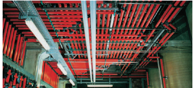
Slika 1 – Cijevni sustavi izrađeni od polimernih materijala, npr. na slici od neplastificiranog poli(vinil-klorida) (PVC-U) (izvor: http://www.gfps.com )
