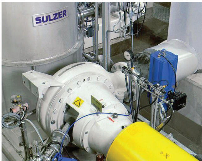
Slika 2 – MCE pumpa s integriranim sustavom otplinjavanja
