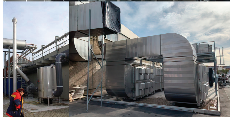
Slika 4 i 5. Primjeri uređaja za fotokatalitičko pročišćavanje zraka
