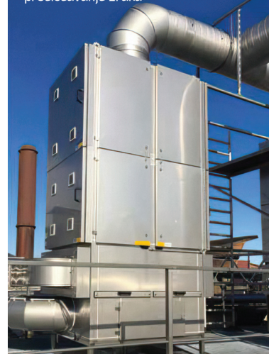
Slika 2. Primjer uređaja za fotokatalitičko pročišćavanje zraka
